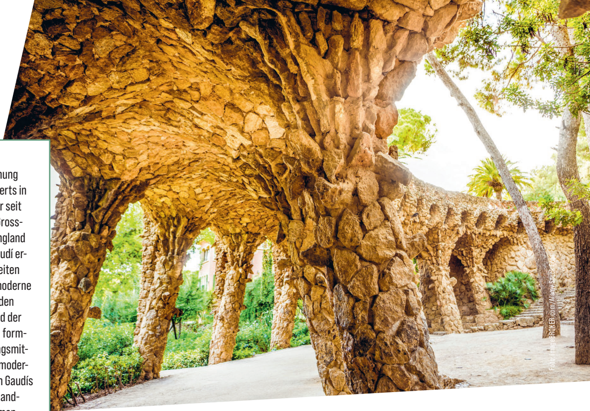
Fussgängerbrücke: Viadukt im Park Güell, Barcelona.
